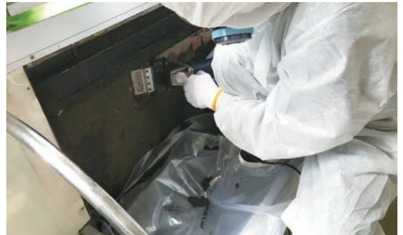
▲アスベスト除去作業中
